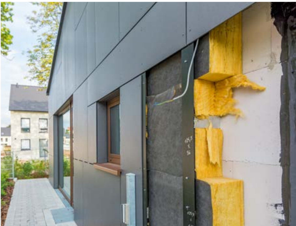
Eine mögliche Maßnahme: Energetische Sanierung durch Dämmung der Fassade.
